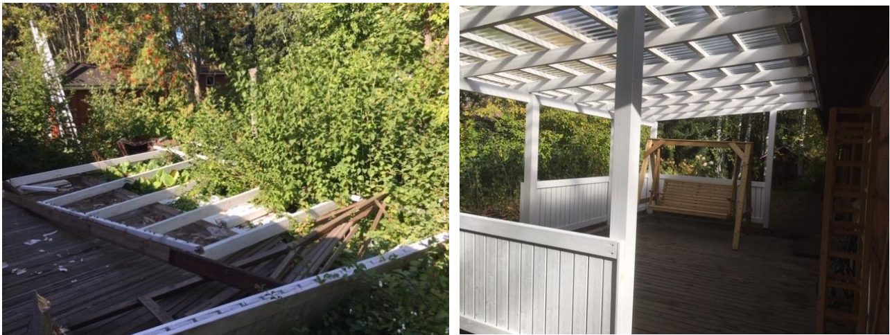
Lumenpainosta sortuneen terassikatteen korjaus
